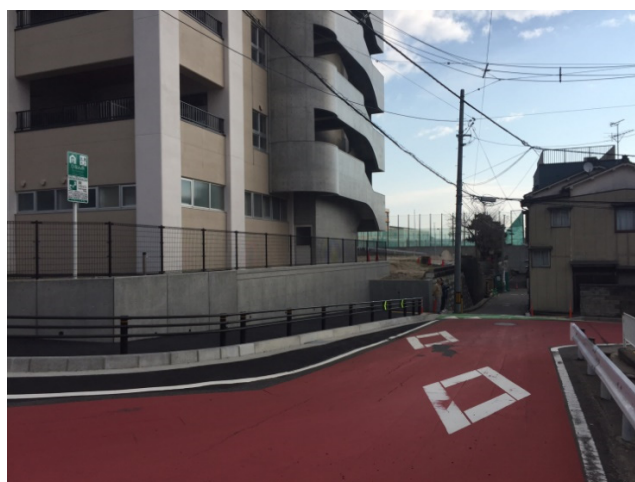
図 2-11 歩道新設（小学校直近）
