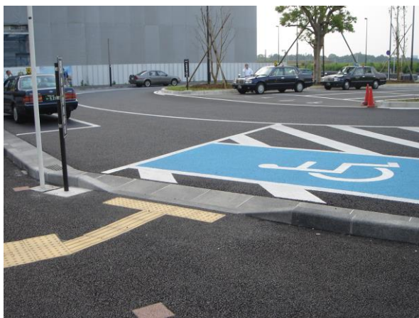
17-3 障害者用乗降スペースも車いす使用者の乗降のための設備であるため、点字ブロックを設置してはならない。（つくばエクスプレス線柏の葉キャンパス駅）
