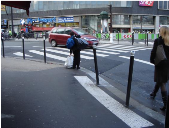
19-2 海外にも日本と同様の誤りがみられる。横断歩道の位置を変更したにもかかわらず、元の場所に点字ブロックがあり、新しい横断歩道前にはない。そのため、横断歩道ではない箇所から道路に飛び出してしまいう危険がある。（フランス・パリ）
