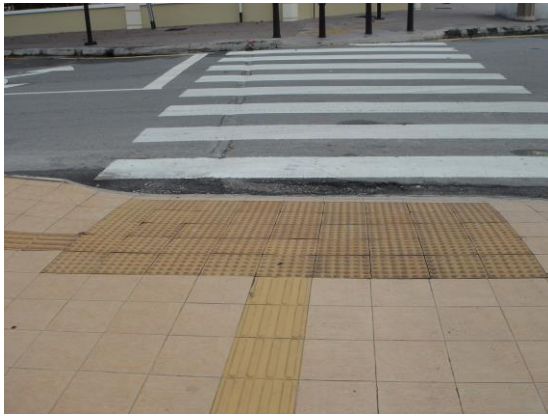
8-11 海外でも横断歩道前に多くの点字ブロックを設置しているケースが目立つ。視覚障害者が迷う原因になる。 (マレーシア・クアラルンプル)
