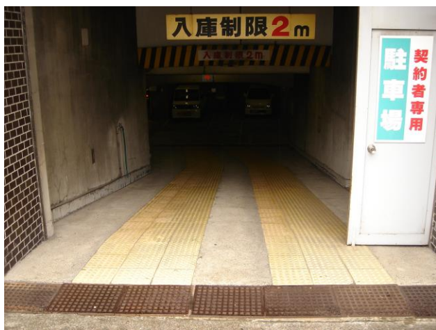
22-1 地下駐車場の入口で、車の滑り止めとして点字ブロックを用いているケースがある。（和歌山市）
