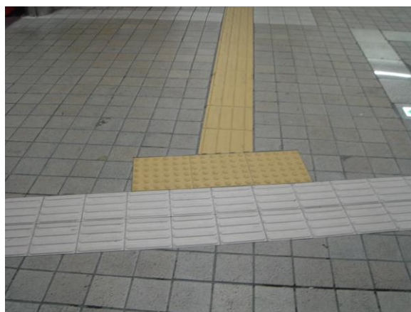
9-5 T字形の交差部分では、このケースのように警告ブロックを設置していることがあるが、左右方向に歩いている（白い誘導ブロックの上を歩いている）視覚障害者は警告ブロックの存在に気がつかない。（韓国・ソウル）
