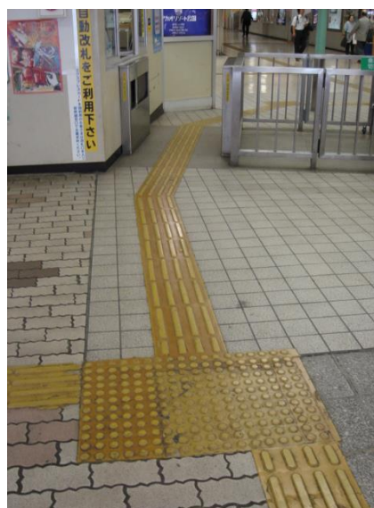
16-2 実際には、幅の広い有人改札に点字ブロックが設置されているケースが多い。（JR 熱海駅）
