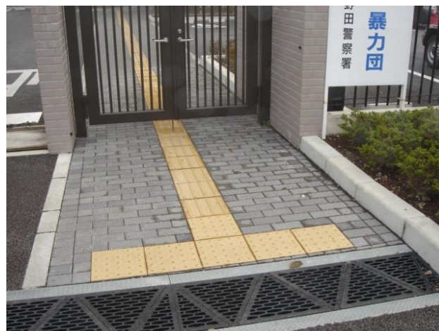
13-1 門の前に警告ブロックを設置すべきである。（千葉県野田市）
