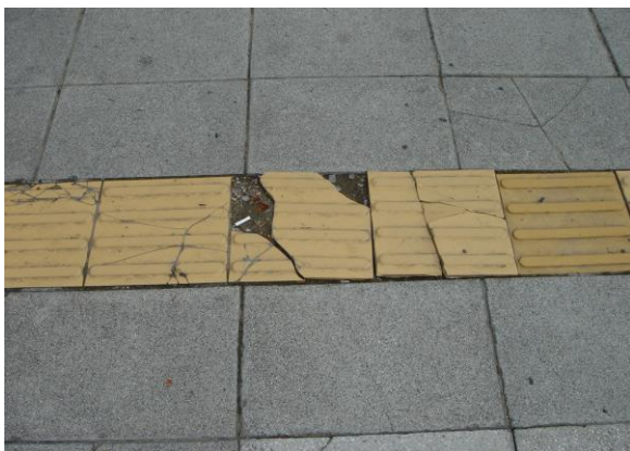
20-5 ブロックが破損したまま放置されているケースである。（韓国・ソウル）
