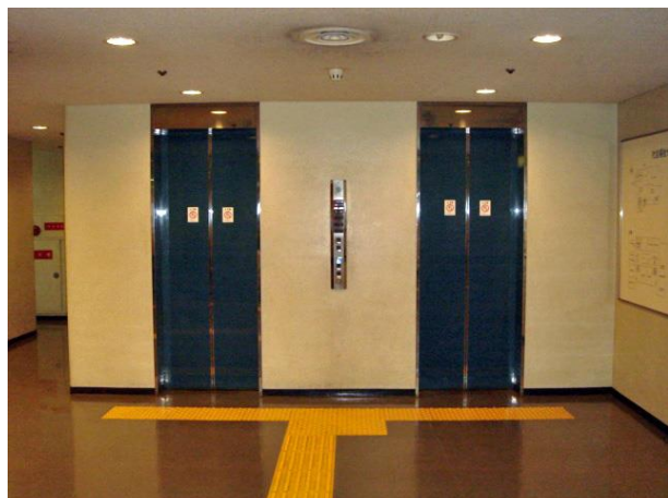
15-1 このケースのようにエレベータ入り口に点字ブロックがあると、車いす使用者のバリアになる。 改善案のように押しボタン前に設置する。(大阪市)
