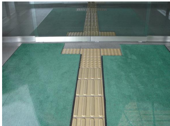
21-6 点字ブロック上にマットを敷くのではなく、このようにブロックの形を残して、ブロックの外側の上にマットを敷くと良い。（広島市）
