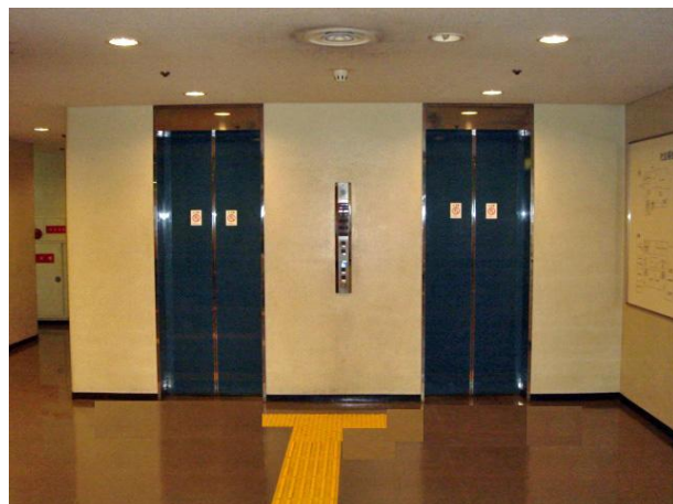
15-1 このケースのようにエレベータ入り口に点字ブロックがあると、車いす使用者のバリアになる。 改善案のように押しボタン前に設置する。(大阪市)
