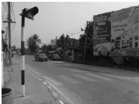
写真5-13 設置された点滅信号
