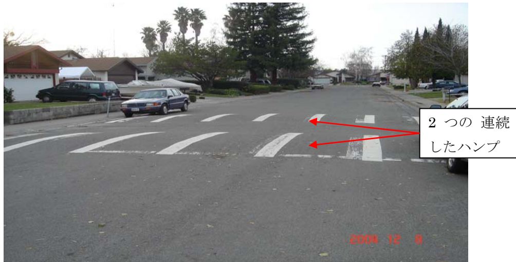
写真 5-2 スピードハンプの連続設置
