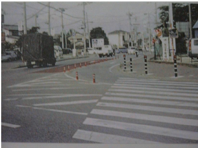
ドット線の設置 歩道の設置 ミラーの大型化
