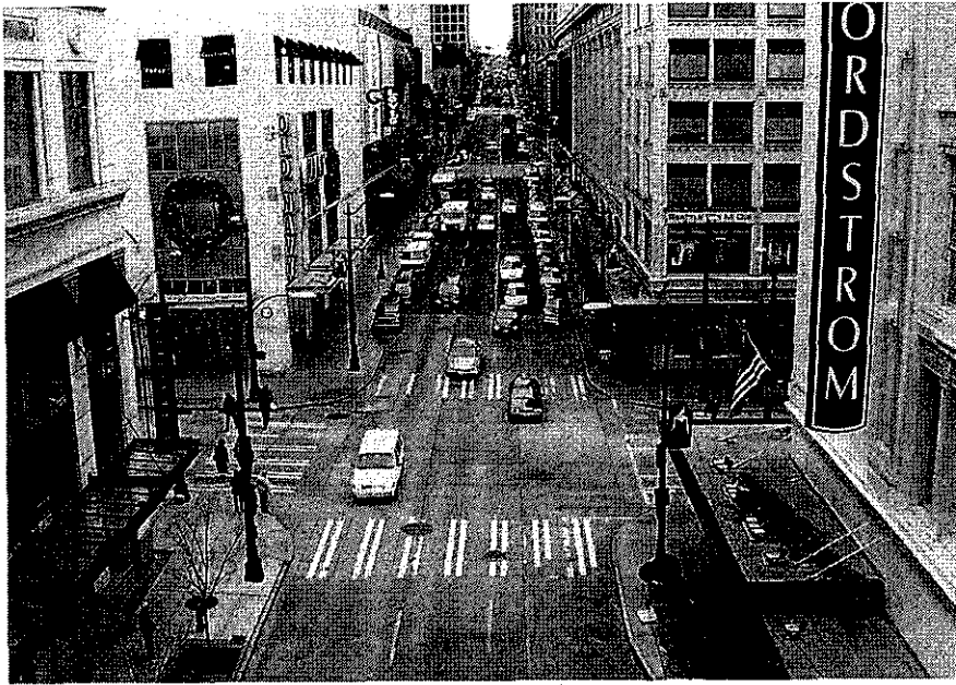
Photo3-1-1 横断歩道部での歩道の張り出しと路側駐車ベイ
