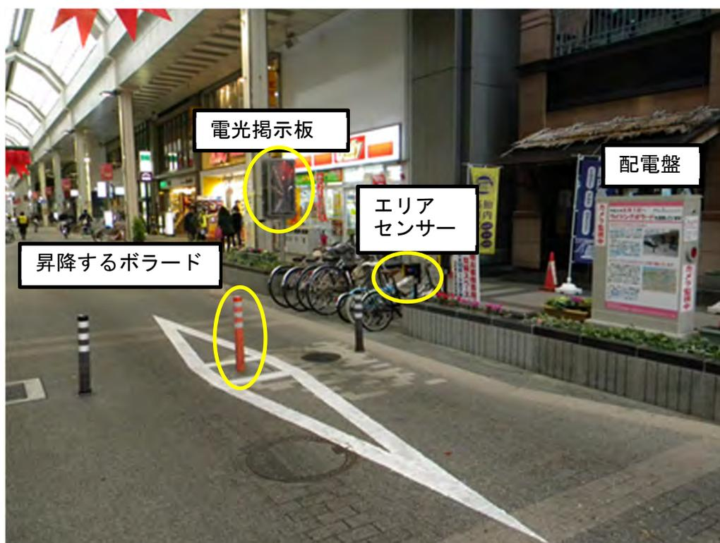
図 2-2 新潟市ふるまちモール6で導入されているソフトライジングボラードシステム
