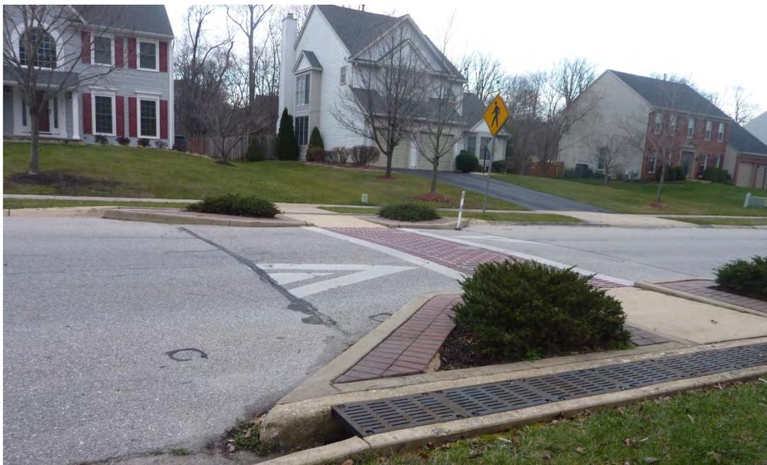
図 3-7 住宅地に設置されているスムーズ横断歩道。平坦部の舗装は住民の希望によりデザイン性の高いものになっている（そのための追加の費用は住民自身の拠出）
