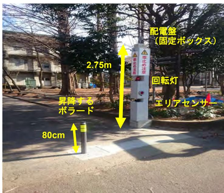
図 2-3 本研究で使用したライジングボラードシステム
