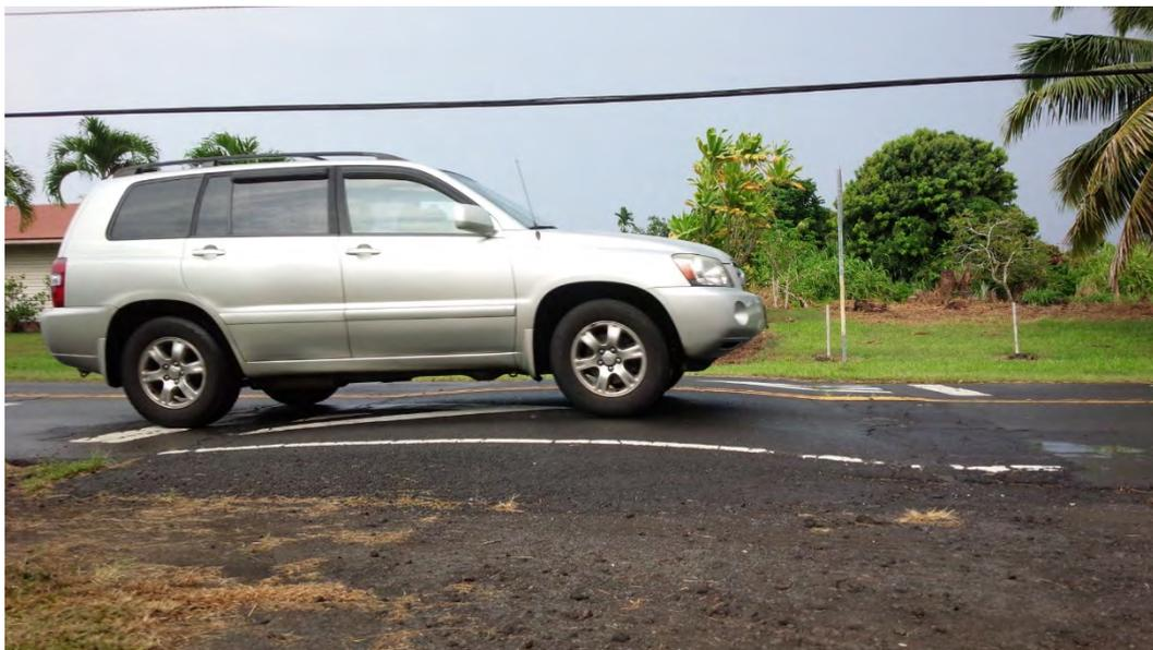
図 3-4 ハワイ郡のハンプ（アスファルトでサイン形状を作っている）
