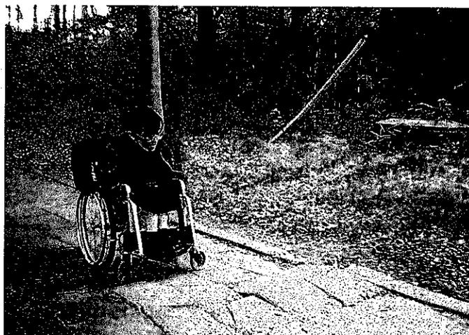
写真48. 木の根が歩道の下から盛り上がっているためにタイルがガタガタになっている。
