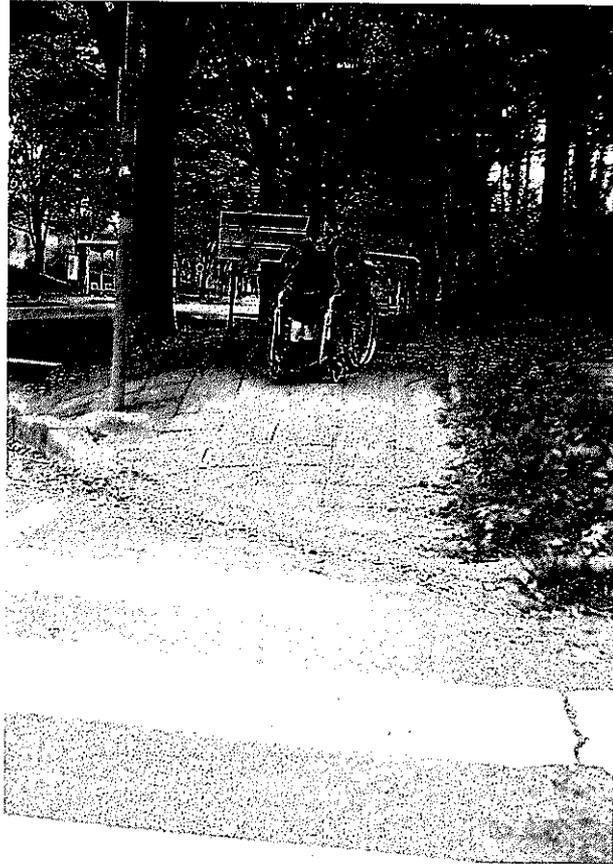
写真40-②. 横断歩道へ降りるための傾斜がきつい歩道。
