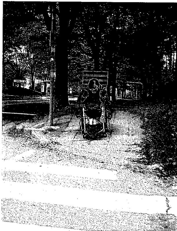
写真40-③. 横断歩道へ降りるための傾斜がきつい歩道。降りる際に車いすのスピードが出て途中で止まることができない。
