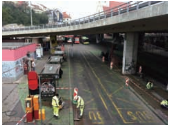
写真 2.42 ブラティスラバのバスターミナル（旧共産圏に典型的なコンクリートむき出しの造り）（2014 年 10 月 29 日撮影）
