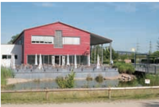
写真 2.2 公園内の拠点施設である自然保護の家（2014 年 7 月 4 日撮影）
