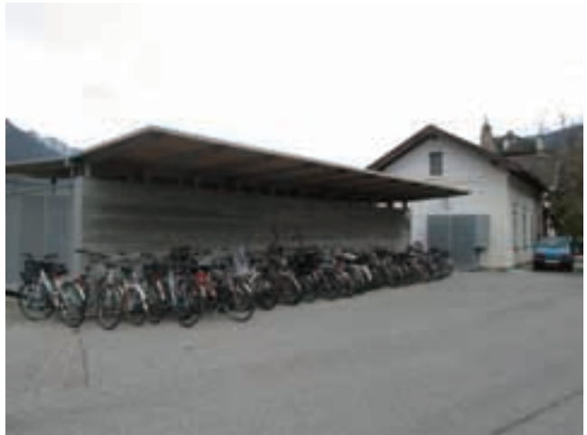
写真 2.30 各駅に設置されている屋根つき駐輪場 (2014 年 10 月 25 日撮影)
