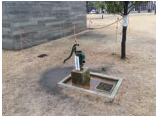
写真 3.14 地下の貯水槽から水をくみ上げるポンプ（2015年2月26日撮影）
