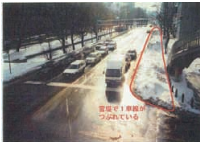
写真 3.3 整備前の冬季の創成川通の様子(札幌市建設局道路課提供資料より)
