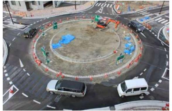
図-C2.5.3 中央部の施工
