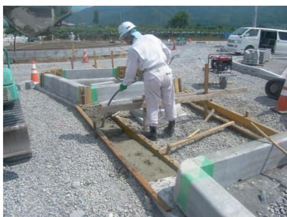
図-C6.5.2 路面排水構造物や縁石などの小構造物の設置
