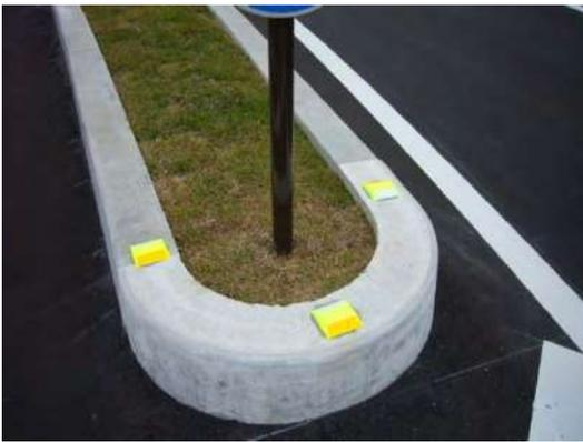
図-C6.5.10 分離島の曲線処理
