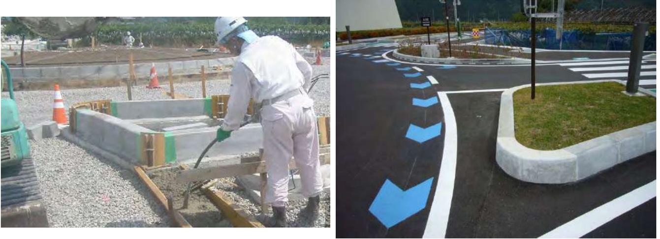
図-C6.5.9 分離島(流出入口)の曲線処理 (左：施工中，右：完成形)
