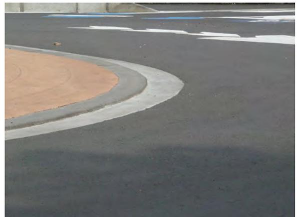
図-C3.3.11 エプロン部の段差構造
