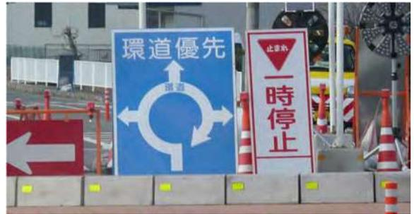
図-C5.4.1 現行法定内の規制・警戒標識設置と法定外看板の仮設置
