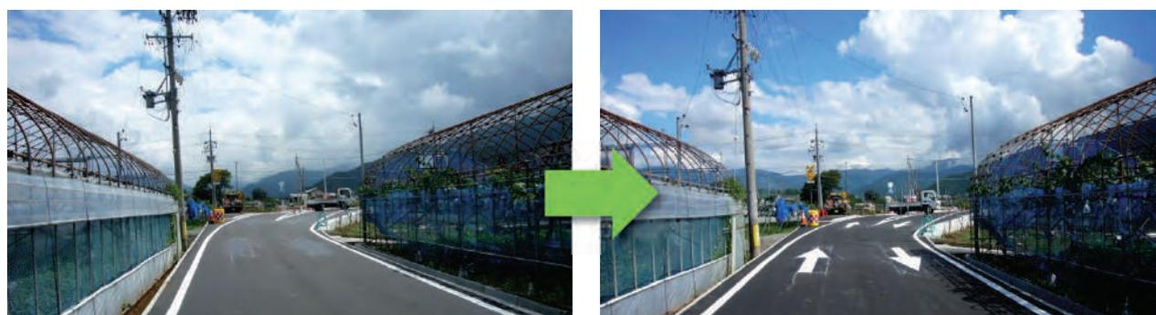
図-C6.5.8 太めの矢印路面標示による流出入の明確化
