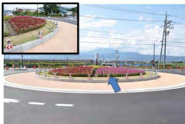
図-2.5 須坂市野辺町ラウンドアバウト 中央島の視線誘導発光灯
