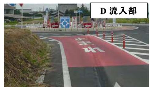
図-C5.3.2 流入部車線幅員の狭小化と主道路の市道笠原立田線への段差舗装
