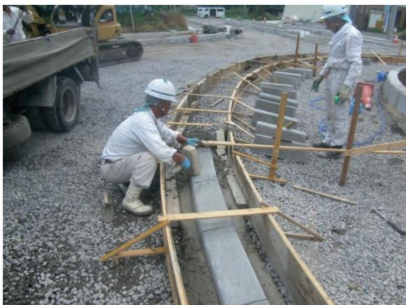
図-C6.5.3 中央島・エプロンの施工
