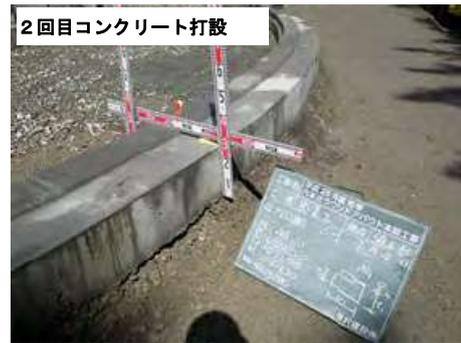
写真-C3.5.2 コンクリート打設状況②
