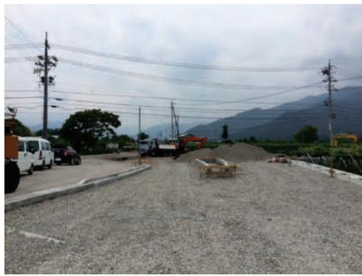
図-C6.5.1 排水施設の整備，土工基面整成（左写真提供：須坂市）
