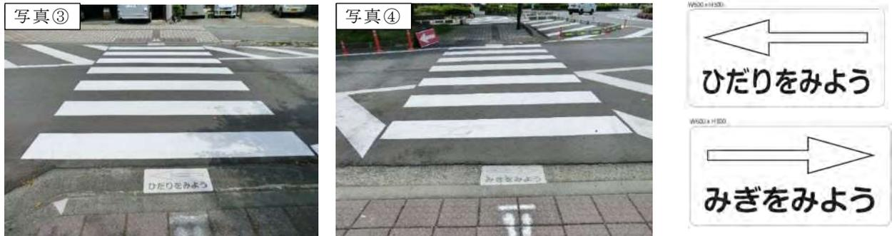
図-C1.4.3 横断歩行者用注意喚起のための路面標示シートの設置例
