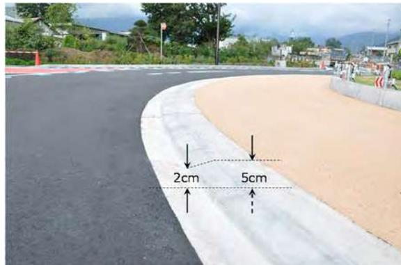
図-2.3 須坂市野辺町ラウンドアバウト エプロン構造
