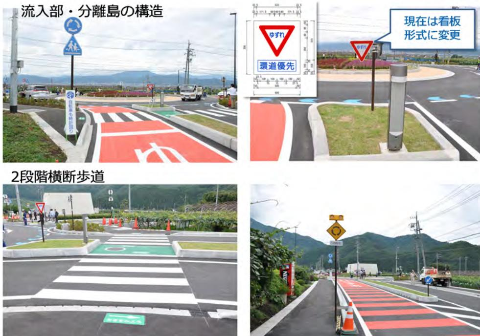
図-2.4 須坂市野辺町ラウンドアバウト 流出入口構造
