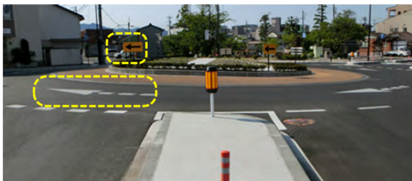
図-2.9 進行方向を示す路面標示と標識
