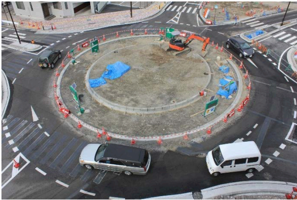
写真-2.14 中央部の施工
