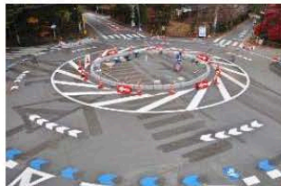
⑤中央島の施工
