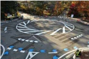
④区画線の設置(2)
