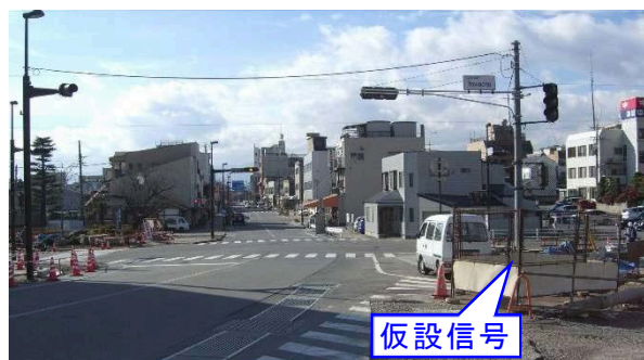
写真-2.5 信号の移設(移設後)
