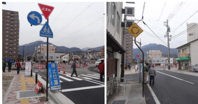
写真-2.9 標識の設置
