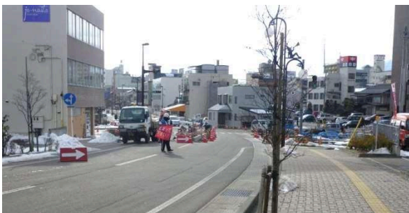
写真-2.1 片側交互通行、交通誘導員の配置
