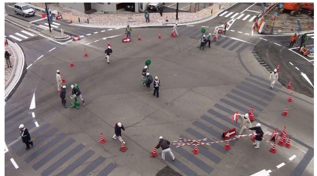
写真-2.11 暫定ラウンドアバウトの切り替え 2
