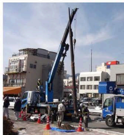
▲信号柱の撤去
