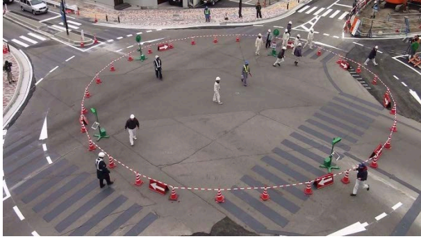
写真-2.12 暫定ラウンドアバウトの切り替え 3
