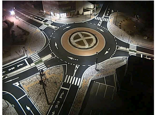
写真-2.15 施工後の状況
