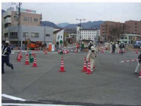
▲カラーコーン等の設置作業
