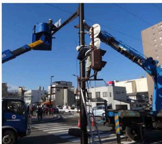
▲灯具，看板等の撤去
