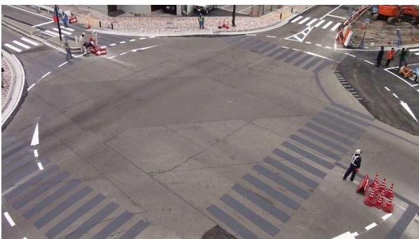
写真-2.10 暫定ラウンドアバウトの切り替え 1
