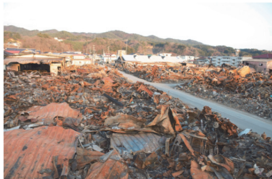
図 5-4-8 火災によって甚大な被害を受けた鹿折地区（2011 年 4 月 12 日筆者撮影）
