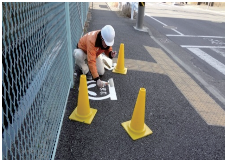
図 31 ストップマーク表示の設置作業
