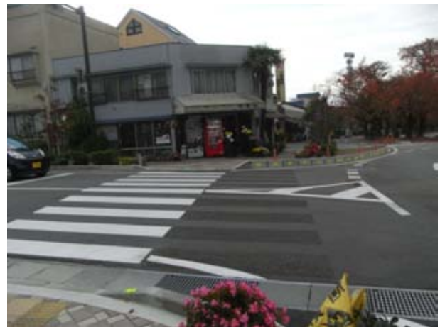
②東部流出入口
