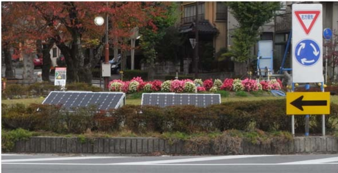
写真-3.1 太陽光パネル設置の様子
