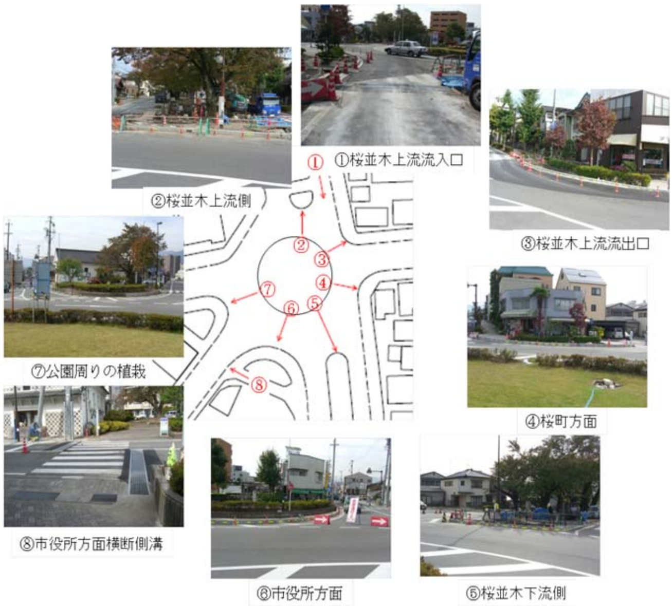
図-3.5 道路構造物改良時写真（撮影：飯田市）
