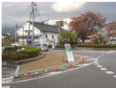
②実証実験PR用看板設置例(SW流出)
