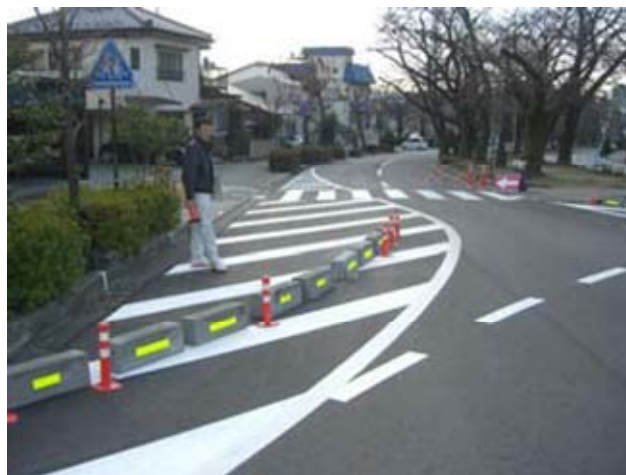
写真-2.2 N流入部付近の単管バリケード
