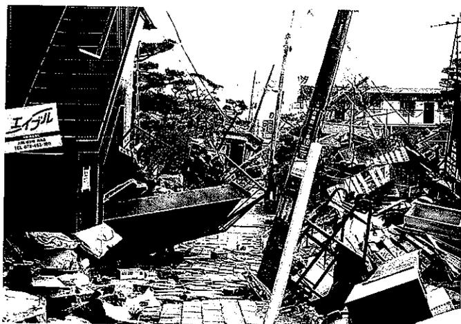
写真-5 沿道のブロック塀や電柱などの倒壊により閉塞された生活道路（幅員4m）（神戸市東灘区）
