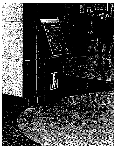
写真22. 駅構内に設けられた点字版案内図。案内図がある場所まで誘導する点字ブロックがないため、結局利用されない（新宿駅）。
