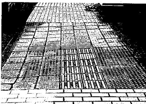
写真39. 警告ブロックと誘導ブロックが一面に敷きつめられている。点字ブロックの役割が果たされていない。
