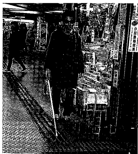
写真32. 点字ブロックの付近に積まれた売店の商品は障害物となる。
