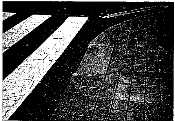
写真30. 韓国の歩道スロープ。 車イスやバギー、高齢者等のために、車歩道の一部がスロープになっている。視覚障害者が車道に迷い出ることを防ぐことができる。
