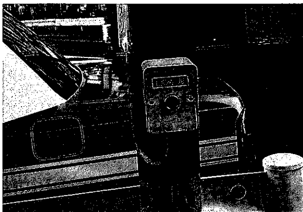
写真23. 音声信号機の押しボタン。設置場所が不統一のため、慣れた場所以外でボタンをさがすのは難しい。汚れていたり壊れているものも多い。
