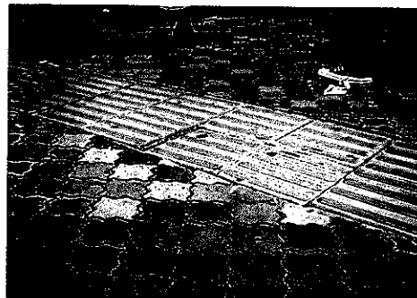
写真41. 陥没したまま放置された点字ブロック。つまずきの原因になる。
