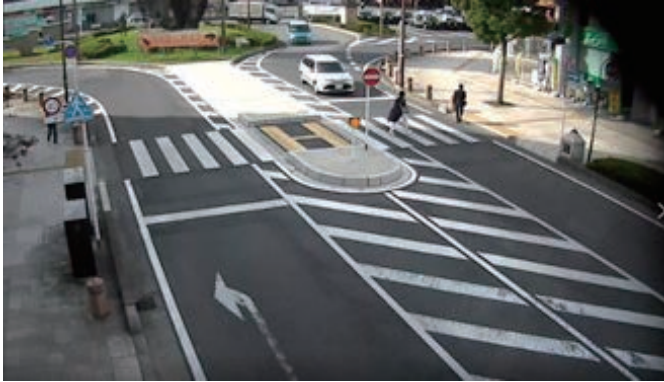
図 6.8 埼玉県春日部市にある二段階横断施設（執筆撮影）。
