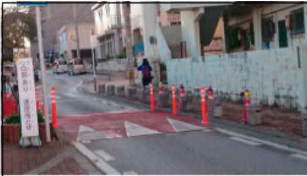
沖縄県浦添市仲西小学校前で実施中のハンプ実験 (長さ6m 平坦部2m) 好評につき、本格実施に移行(2015年8月)
