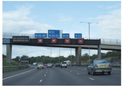
図6 車線別可変速度規制の例(イギリス)
