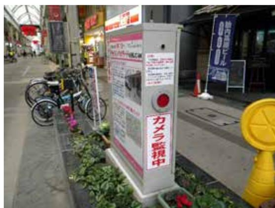
写真 3-9 ソフトライジングボラードの制御盤
