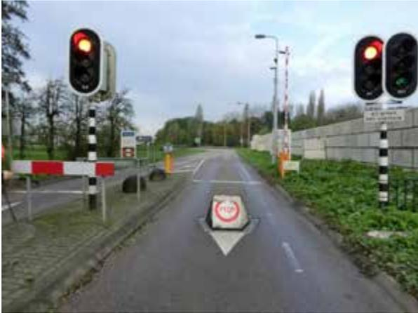
写真 2-8 フィアーンネン市に設置されているライジングバリケード
