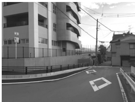
Fig. 11 歩道新設(小学校直近)
