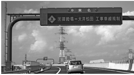
Fig. 1 多色表示可変情報板設置例
