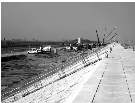
Fig.4 仙台湾岸で進められている防潮堤工事：2013年8月撮影
