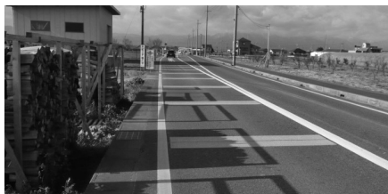
Fig. 13 段差舗装の設置
