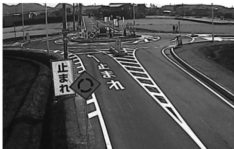
Fig. 6 実験中の交差点状況：平成26年1月31日撮影
