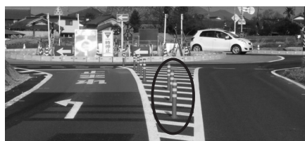
Fig. 12 ポストコーンの追加設置
