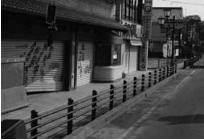
Fig. 5 松島の被災状況
