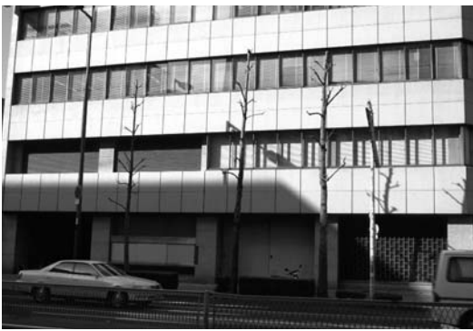
Fig. 10 強度に剪定された街路樹
