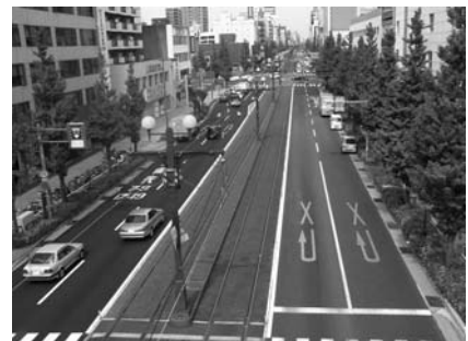
Fig. 2 整備されたセンターポールと芝生軌道
