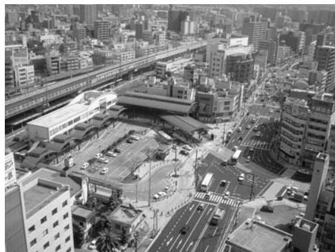
Fig. 16 停留場移設後の横川駅周辺
