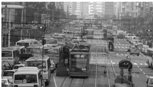
Fig. 3 軌道敷内諸車乗入禁止および区画線設置状況
