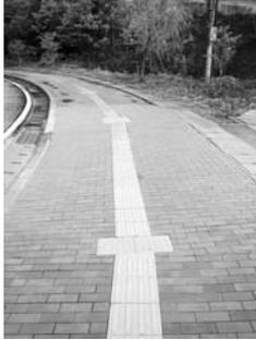
Fig. 16 注意を促す必要がない場所に警告ブロックを設置している例：長崎県対馬市
