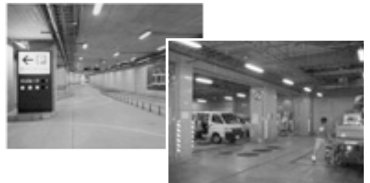
Fig. 6 大規模地下車路と地下荷捌き施設(品川インターシティ)
