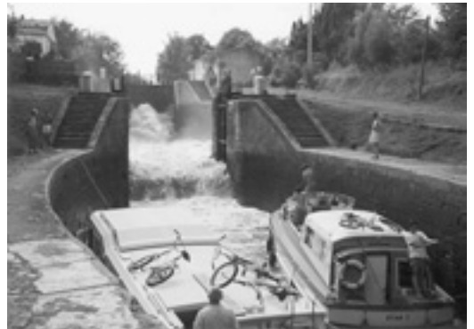
Fig. 2 ミディ運河の卵型連続ロックとプレジャーボートの航行
