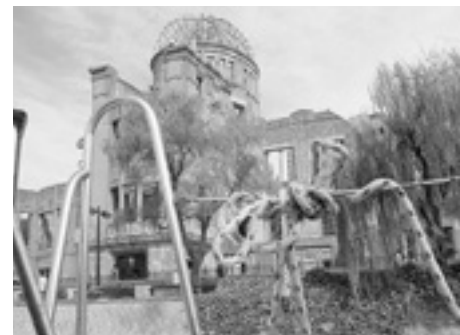
Fig. 12 世界遺産ルートの運河拠点/原爆ドームを船から望む
