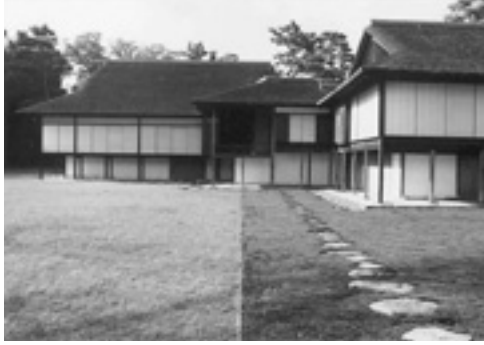
Fig. 7 雁行状に並ぶ書院群の水害対応型の高床
