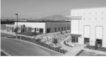
Fig. 1 CE CERTの新築施設:左側は管理棟で、右側は研究棟
