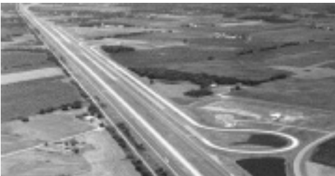
Fig.3 舗装試験施設
