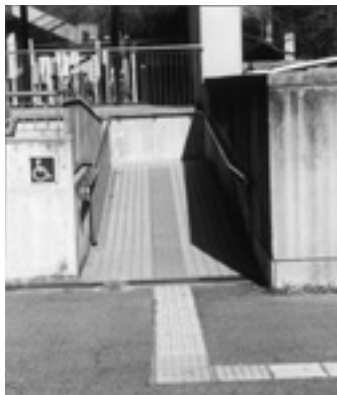
車いす用スロープに点字ブロックが併設されているT市の市民会館の正面入口。
