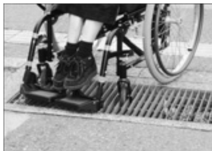
車いすの前輪がはまってしまうグレーチングの例。自力での脱出は難しい。
