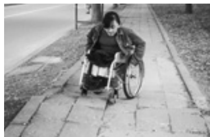
凸凹のタイルは歩道走行上の大きな妨げとなる。
