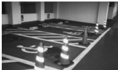
T市福祉会館の身障者用駐車スペース。パイロンが置かれており、また管理者が近くにいないため結局は利用されない。 Fig. 10
