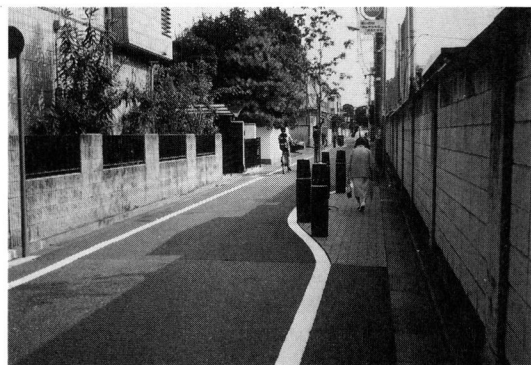
車いすを含む歩行者の通行に配慮した物理的デバイスの設計例 Fig.4 コミュニティ・ゾーンに設置されたシケイン (東京都三鷹市)
