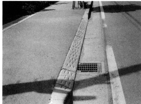
Fig.2 特殊縁石を利用した歩道の平坦化
