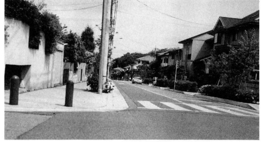
改善後／歩道を拡幅し、2mの歩道と1mの植栽帯を両側に設置
