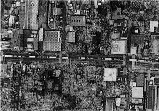
Fig.3 街路樹のある通りを隔てて飛び火した菅原変電所付近の航空写真
