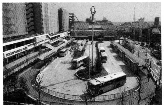
バス停部分の屋根が張り出している
