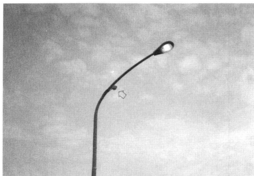
Fig. 5 ビーコンの設置状況（アンテナ部）
