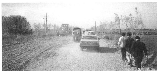
農村部での道路工事
