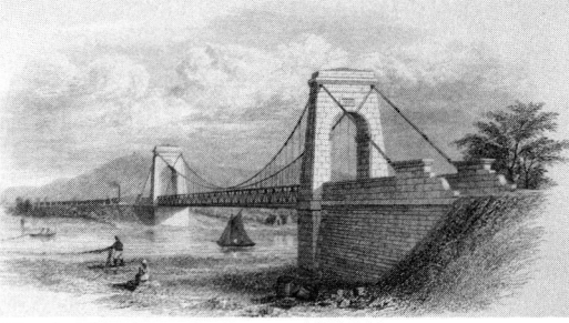
Fig. 1 Stockton-Darlington 鉄道吊橋 (1987年7月、イギリス土木学会で筆者複写) Stockton-Darlington railway suspension bridge
