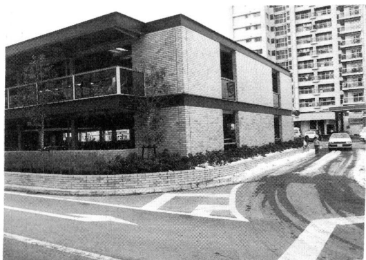
Fig. 2 洗練された形態の自転車駐車場の建屋(国鉄根岸線根岸駅、1984年2月撮影)
