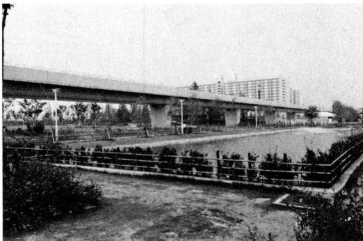
Fig. 5 南港ポートタウン線 (大阪) The new transit system in Nanko Port Town (Osaka)
