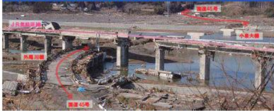
▲22気仙沼市本吉町下宿地内(外尾川橋・小泉大橋)
