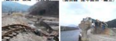
C【線路流失】 (山田線 磯崎～津軽石) D【横けた流失】 (山田線 陸中山田～雄左)
