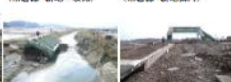
J【運床流失】 (仙石線 野森橋内) K【横けた流失】 (常磐線 新地～坂元) L【線路流失】 (常磐線 新地橋内)
