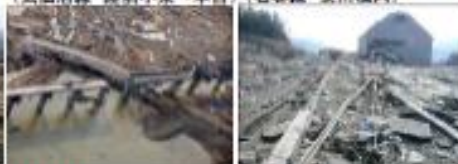
J【運床流失】 (仙石線 野森橋内) K【横けた流失】 (常磐線 新地～坂元) L【線路流失】 (常磐線 新地橋内)
