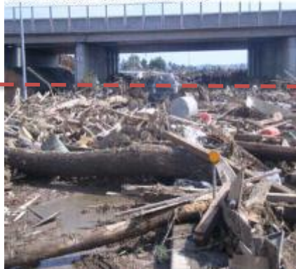
(1) 仙台東部道路・青林JCT 上下線ランプにおける被害状況 (3月12日撮影) 津波によって押し流された堆積物が上下線ランプに流入。
