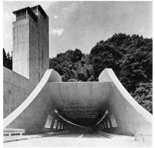
Fig.5 恵那山トンネルのルーバーと換気塔 Portal louver and ventilation tower of Enasan Tunnel
