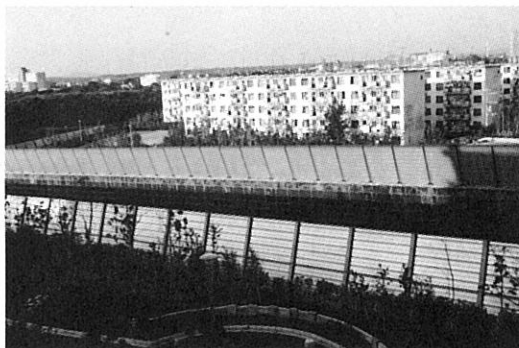
写真 防音壁で保護される団地 A housing-complex protected by soundproofing walls
